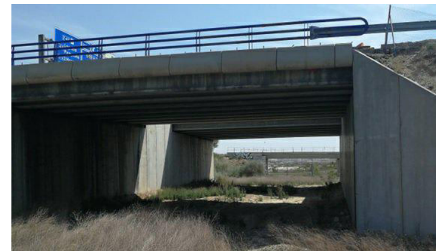
Detalle fotográfico Paso inferior
